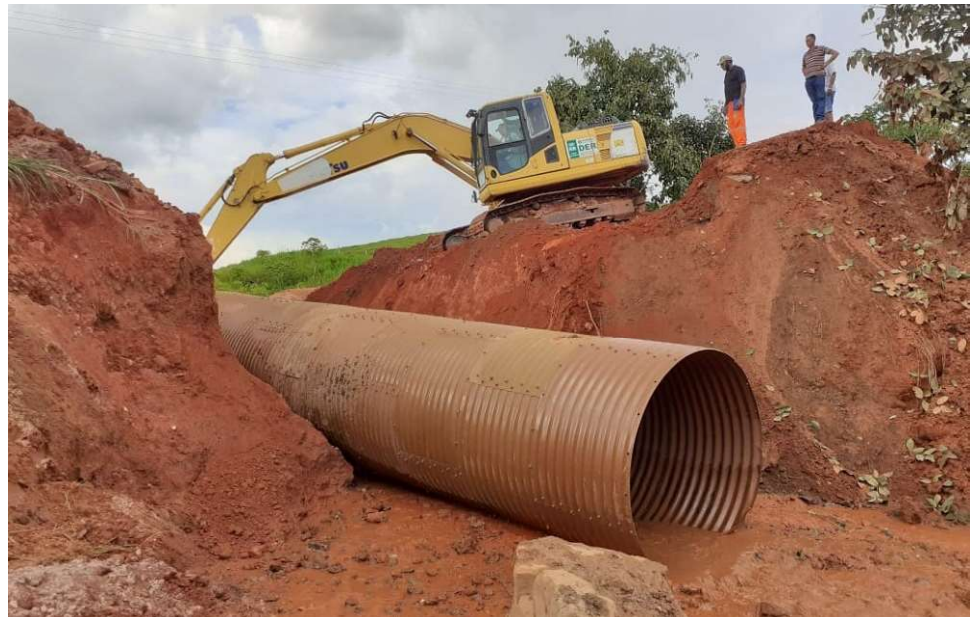
Obra é importante e oferece mais acessibilidade para a população.
