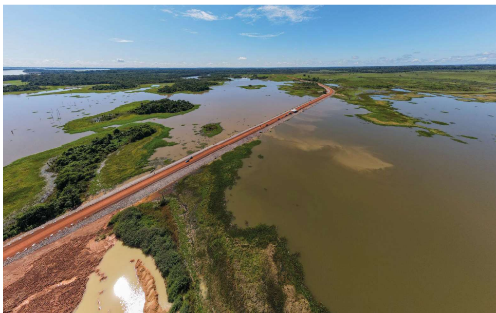
A obra do novo acesso, que foi entregue em 2023
