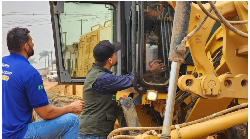
Deputado acompanhou a obra e conversou com servidores
