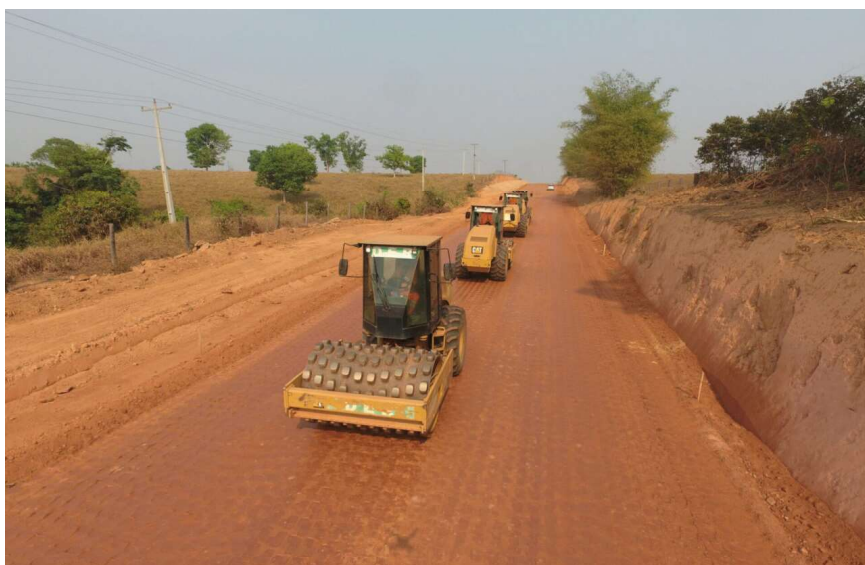
A via está sendo restaurada saindo do município de Ariquemes sentido o distrito do 5º Bec
