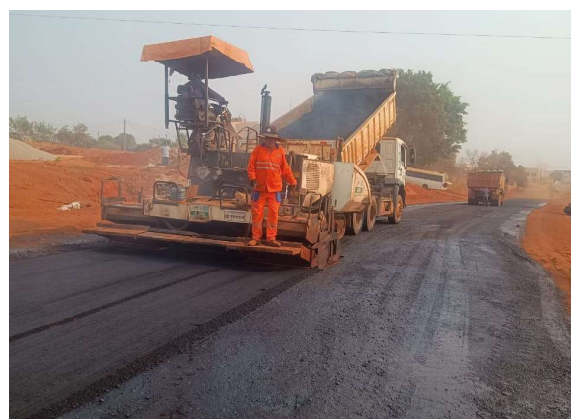
Serão pavimentados 900 metros de asfalto novo na Avenida Getúlio Vargas
