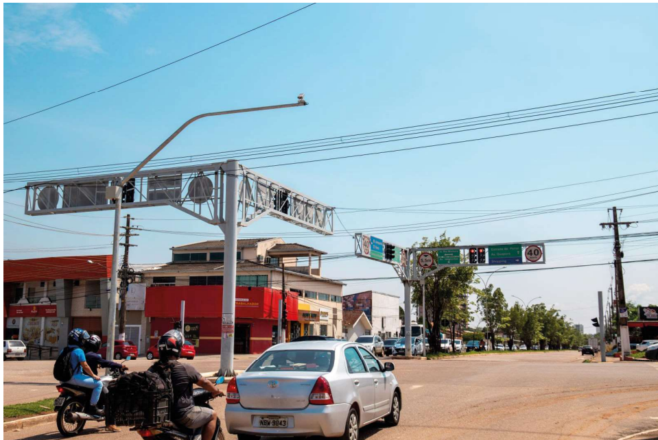
As câmeras estão sendo instaladas em três cruzamentos com grande fluxo de veículos
