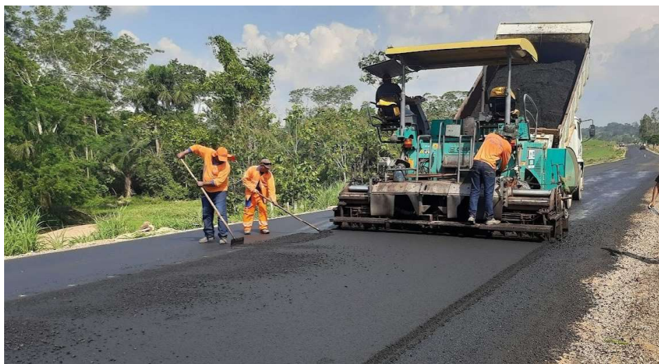
Estão sendo recuperados 54 quilômetros da rodovia RO 460
