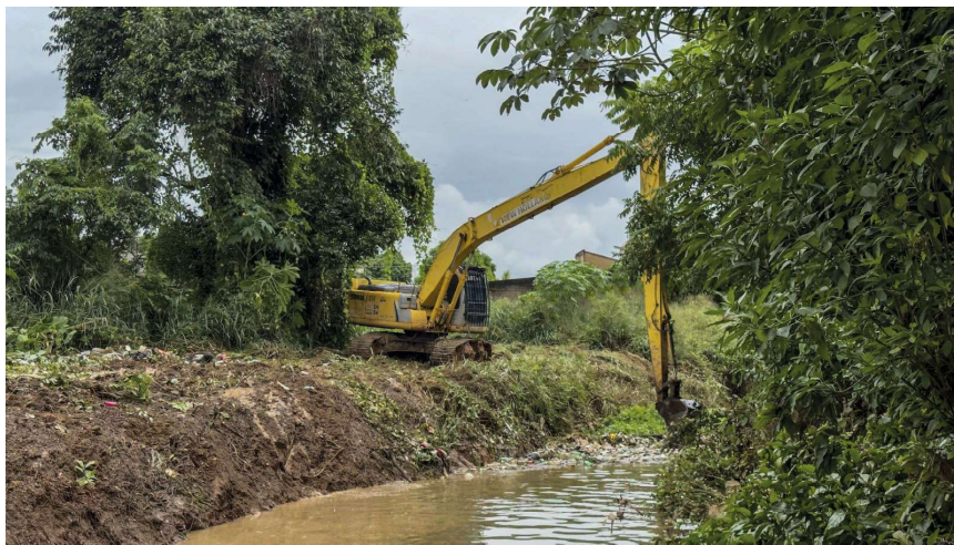
Equipes da Semob estão realizando diversas intervenções nos pontos afetados, tendo como foco áreas atingidas por alagamentos
