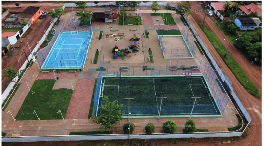
Construção da praça em Nova Califórnia já está em fase de conclusão
