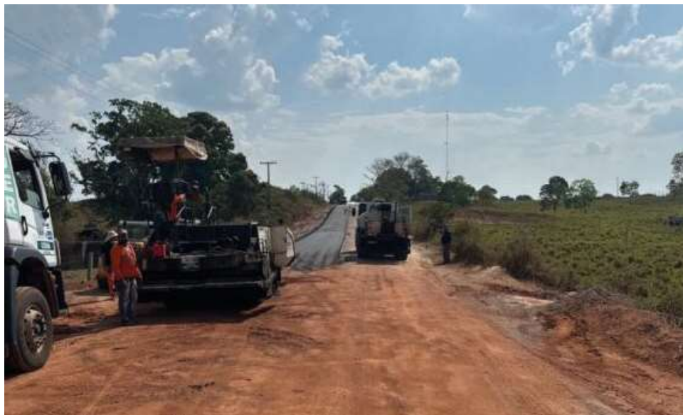
Usina de Asfalto do DER executa pavimentação de trecho da RO-133 em Nova Colina
