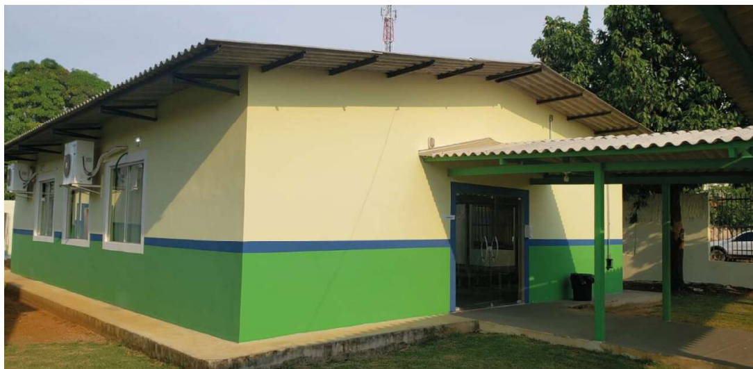
Uma das escolas recebeu três salas de aulas e a outra um novo auditório, passarela coberta e pintura geral de paredes, calçadas e portas.
